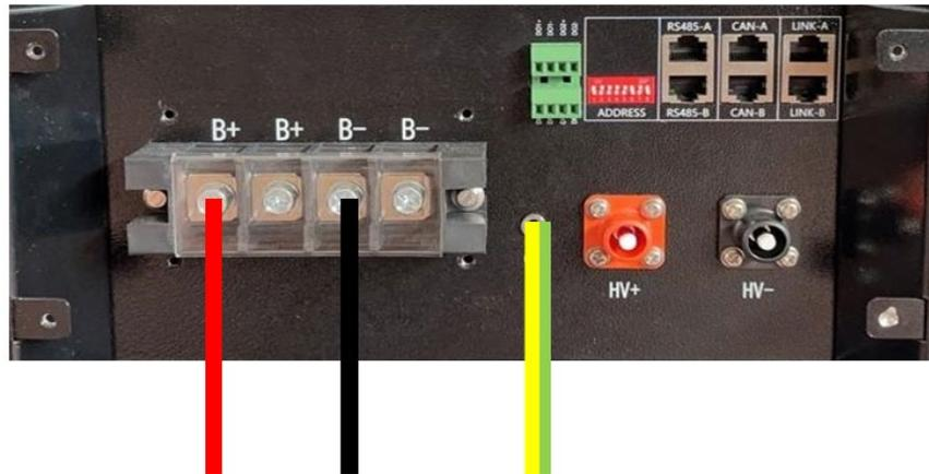
Figura 27 - Connessione batteria WeCo 5k3
